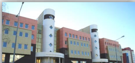
Политехнический институт, г. Мирный
